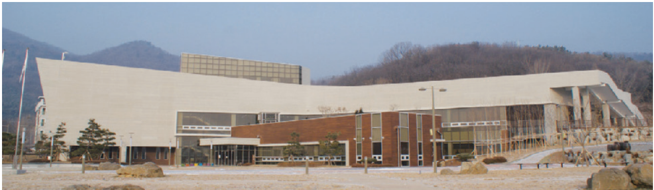
남양주 유기농 박물관 전면 시공
